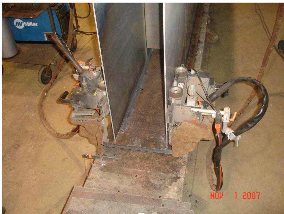
Jednoczne spawanie dwoma wózkami – profil skrzynkowy
