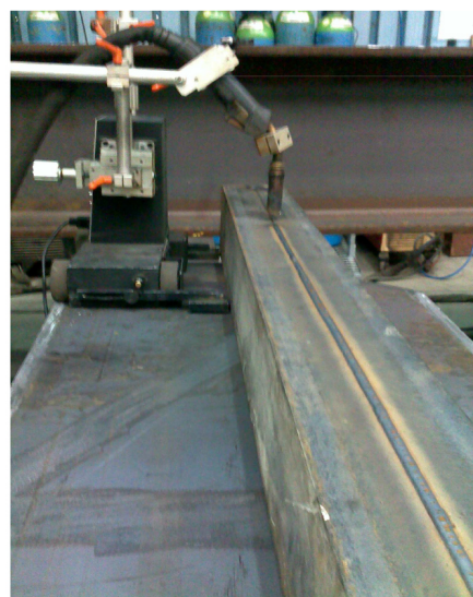
Spawanie doczołowe – dwa ceowniki
